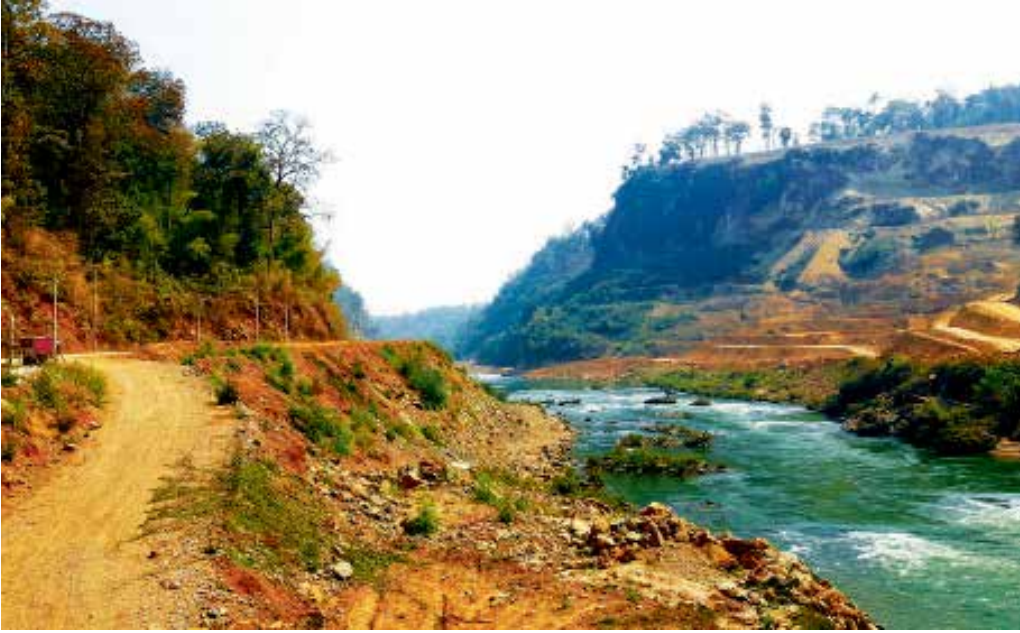
အထက်ရဲရွာရေကာတာ တည်ဆောက်ရာဆိုဒ်
