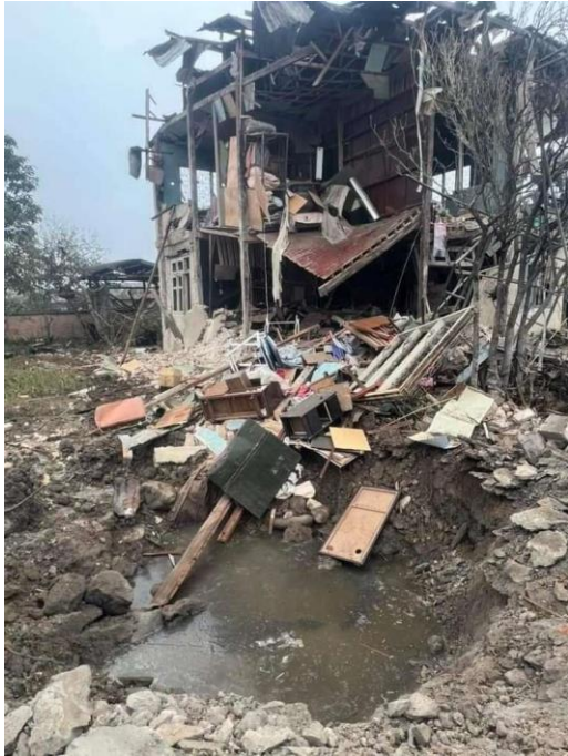
နမ့်ခမ်းမြို့ ပေါက်နေရပ်ကွက်တွင် စစ်ကောင်စီ၏ လေကြောင်းတိုက်ခိုက်မှုကြောင့်ထိခိုက်ပျက်စီးမှု
